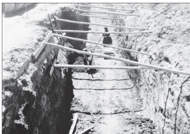
اولین پروژه احداث شبکه آب و فاضلاب اصفهان
