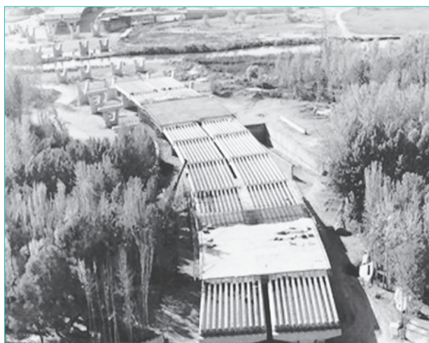
ساخت پل بزرگ غدیر خیابان آبشار - مشتاق سال ۱۳۷۶
