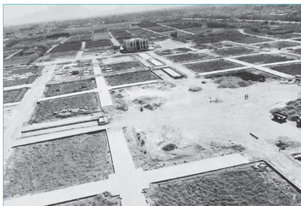
نمایی از ساخت مجموعه باغ‌غذیر در سال ۶۷
